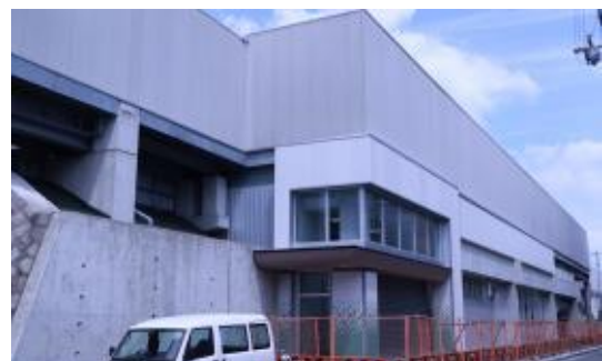
城北公園通駅 工事の様子
