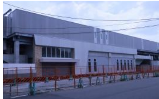
JR淡路駅 工事の様子
