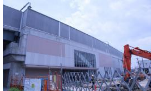
南吹田駅 工事の様子
