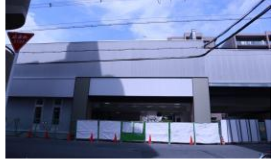
JR野江駅 工事中的の様子
